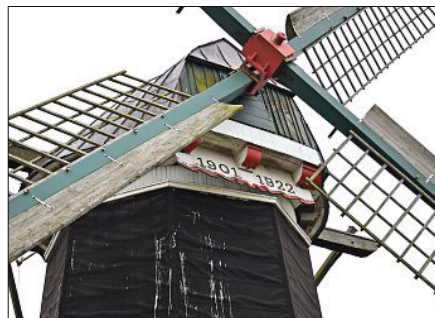
Die einstige Wasserschöpfmühle im Großheider Ortsteil Südcoldinne muss restauriert werden. FOTO: HEINENBERG
