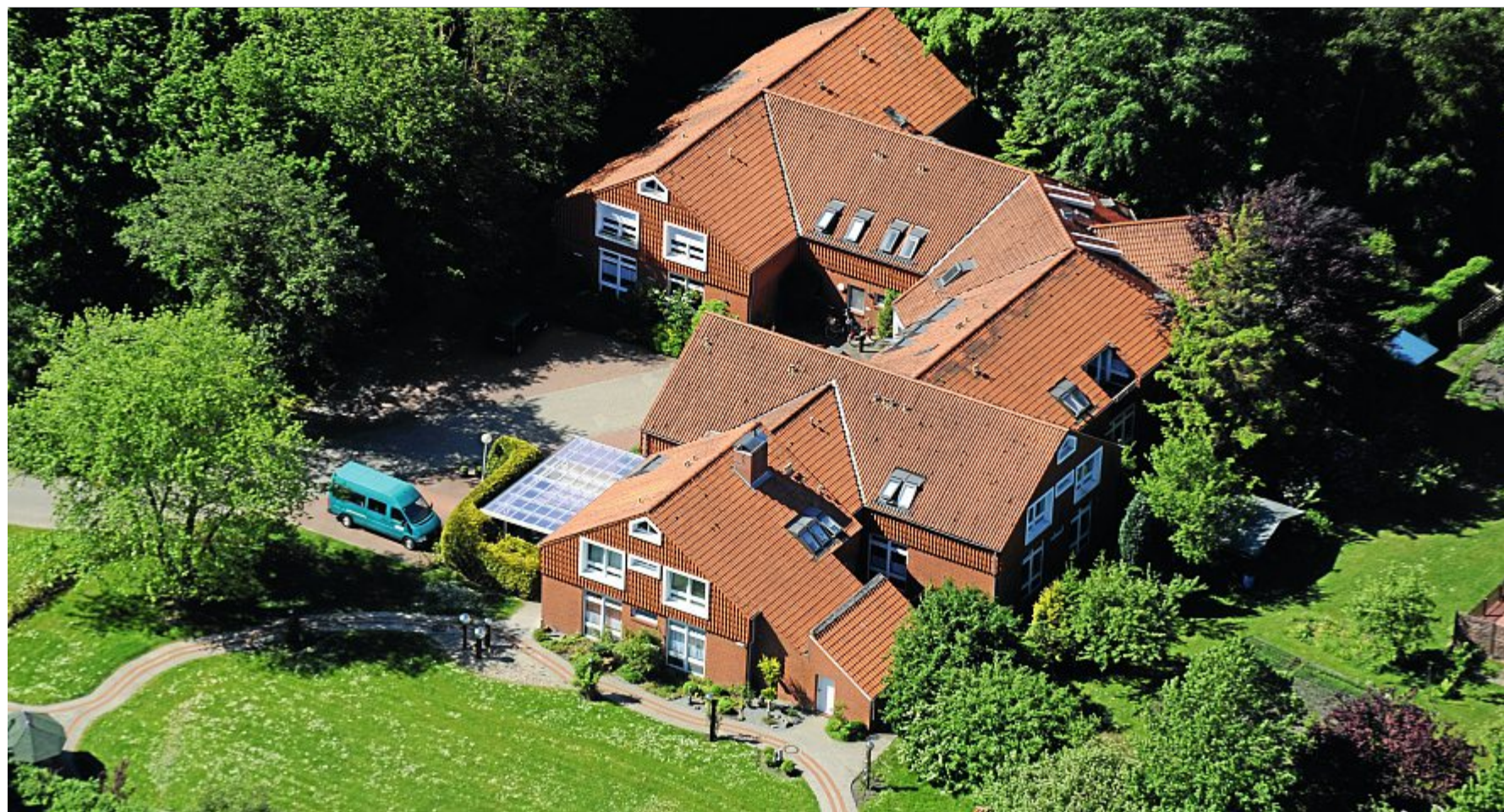
Den Bewohnern der drei Norder Wohngruppen wie der im Haus Uldinga fehlt seit der Schließung der Werkstätten ihre gewohnte Tagesstruktur, was zunehmend zur Belastung wird.
