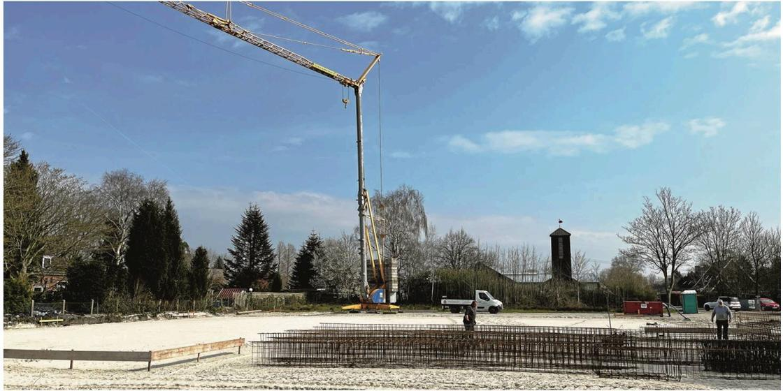
Das Baufeld an der Donaustraße ist vorbereitet. Stahlmatten für die Bodenplatte liegen bereit und der Baukran befindet sich im Aufbau.
